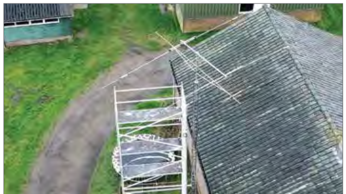
Van dichtbij antennes controleren met een drone
