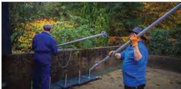
Antenne bouwen Dennenheul
