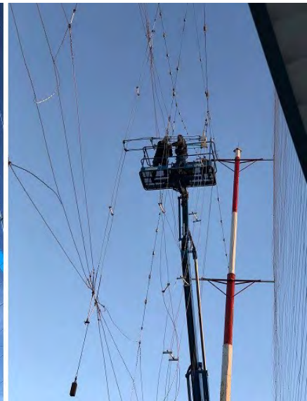
▲ Werkzaamheden aan de antenne om deze geschikt te maken voor hogere vermogens.
