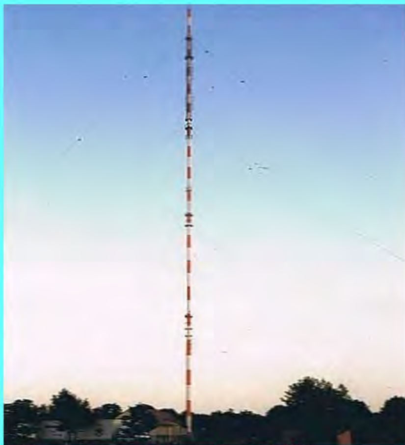
De RTV mast op de locatie Schwerin / Zippendorf, (DEU). The RTV mast at the location Schwerin / Zippendorf, (DEU). Via Rijn Muntjewerff, 22-07-1998.
