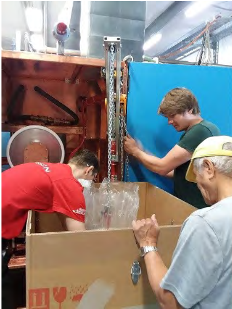
▲ Technici van het bedrijf Ampegon installeren de RF-buis van de WMLK-zender
