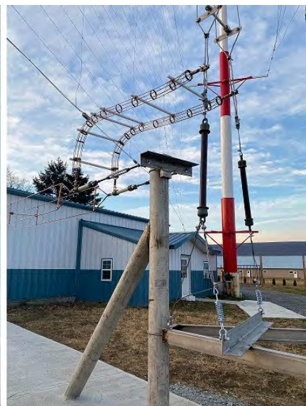
▲ Dit is de voedingslijn van de zender naar de antenne
