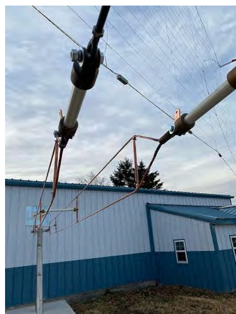
▲ De balun voedingslijnen van de zender naar de antenne.
