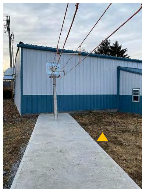
▲ De balun voedingslijnen van de zender naar de antenne.
