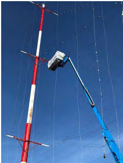
▲ Werkzaamheden aan de antenne om deze geschikt te maken voor hogere vermogens.
