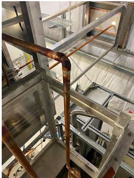
▲ De koperen pijpen zijn onderdeel van de antennetoevoerlijn
