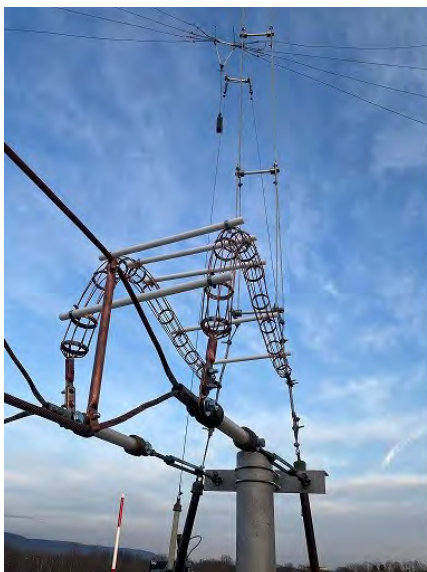
▲ Dit is de voedingslijn van de zender naar de antenne
