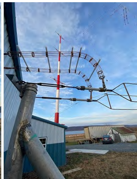
▲ Werkzaamheden aan de antenne om deze geschikt te maken voor hogere vermogens.
