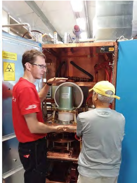
▲ Technici van het bedrijf Ampegon installeren de RF-buis van de WMLK-zender
