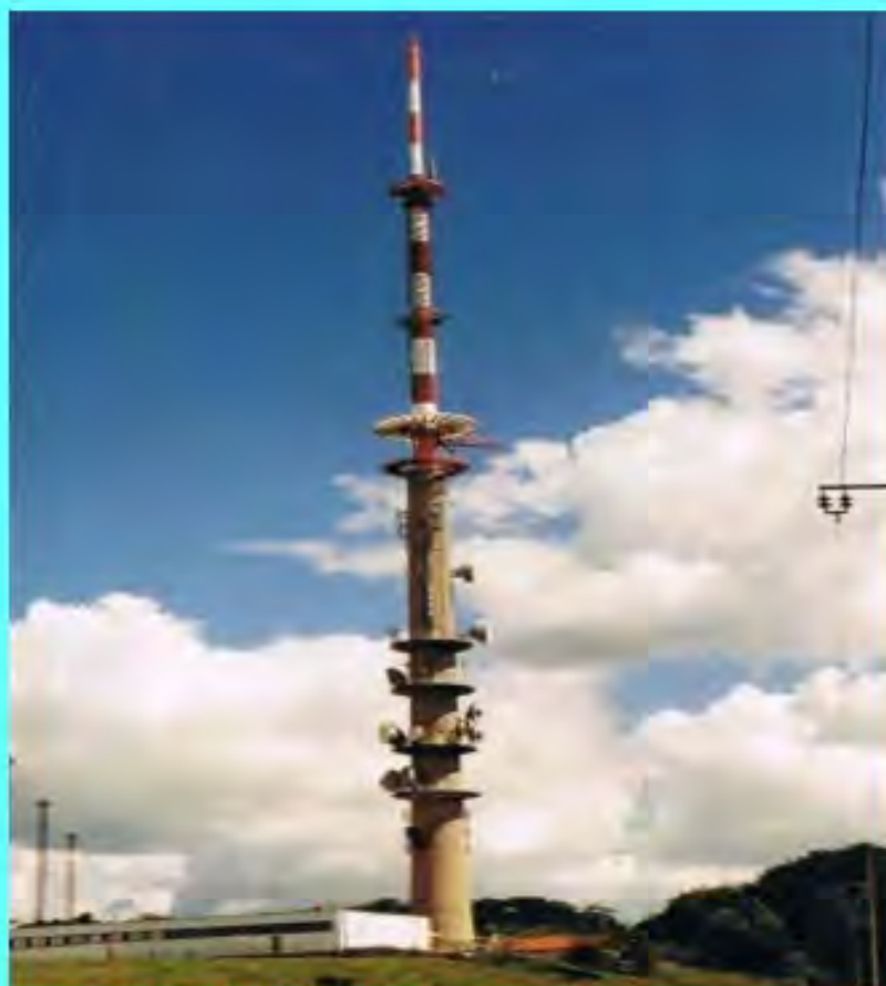
De RTV toren op de locatie Helpterberg, (DEU). The RTV tower at the location Helpterberg, (DEU). Via Rijn Muntjewerff, 31-05-1997.
