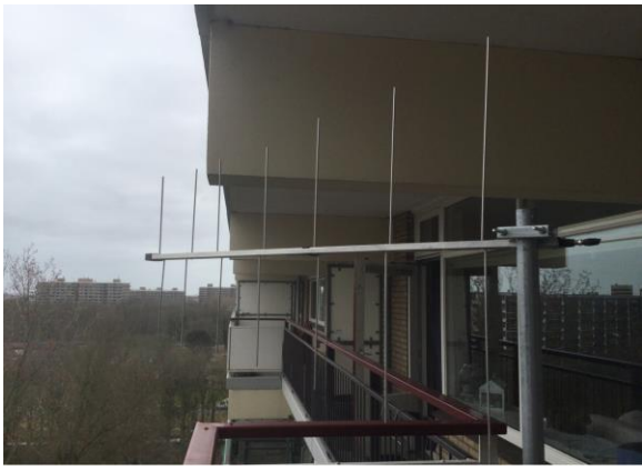
Mijn 14 element lo periodic richting België en Frankrijk Emme Esse 14 element Log periodic link: https://www.emmeesse.it/en/antennas
