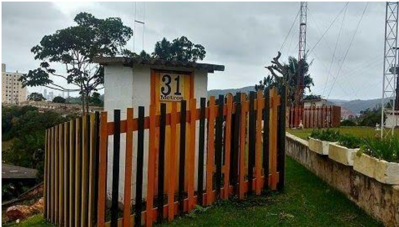
Hokje waar het koppelsysteem voor de 31m zender is ondergebracht
