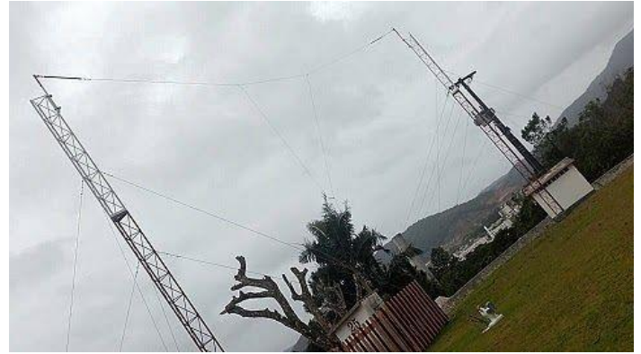
Rhombisch antennesysteem voor de Tropenbanden.
