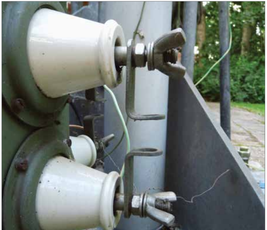
Antenneschakelaar/isolator ex ussr; let op de L-vorm vonkenbruggen waartussen edelgaspatronen kunnen worden aangebracht.
