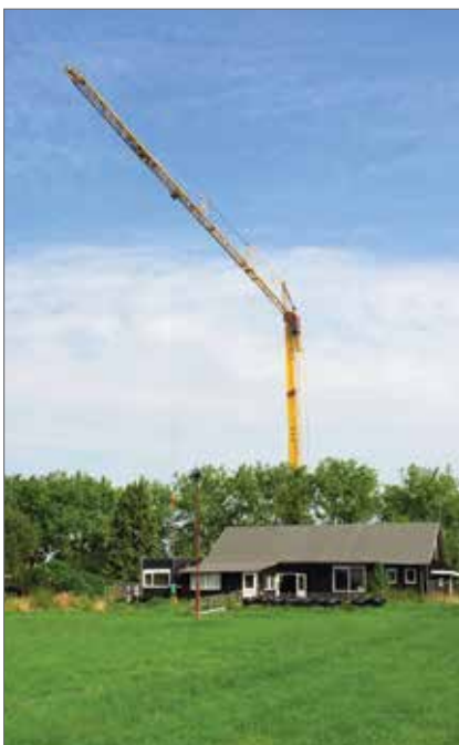
Nieuw clubgebouw wordt geplaatst
