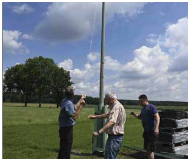
Afb. 1 | Werkzaamheden aan de full-size monoband dipool voor 40 meter.
