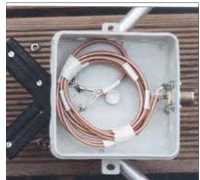
Het middenstuk en de installatiedoos, van boven gezien.
