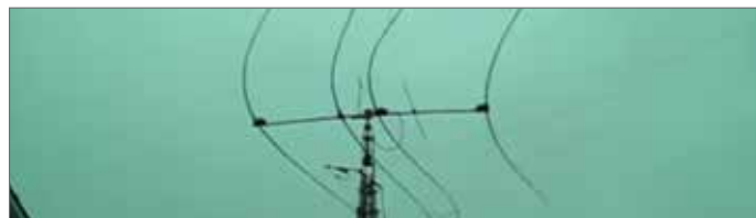
Antenne verbogen door de wind
