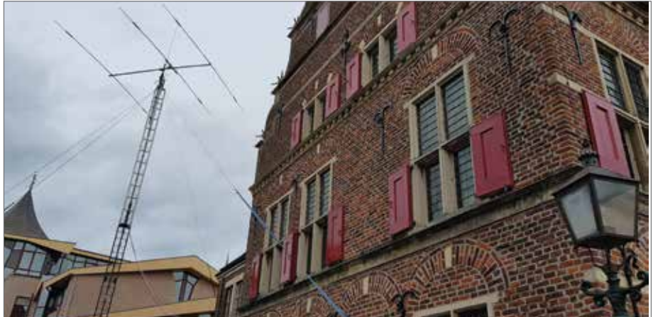
Foto 1 | De 3 elements-HF-beam, met daarachter het nieuwe stadhuis
